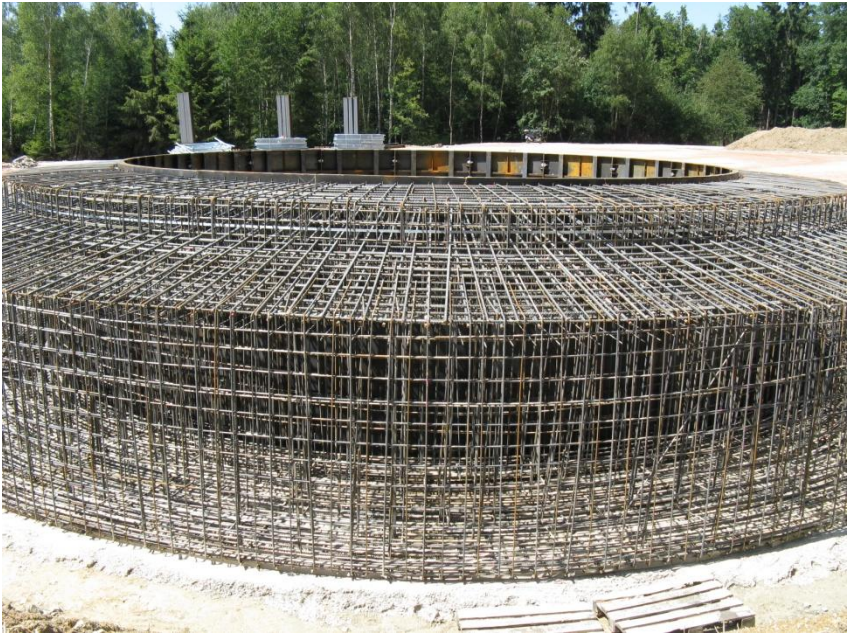
Eisenarmierung im Fundament
