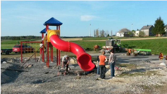
In der Bauphase
